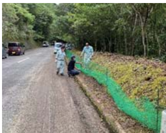
左：事故多発地点に設置する移動式看板 右：アマミノクロウサギ道路進入防止ネット
