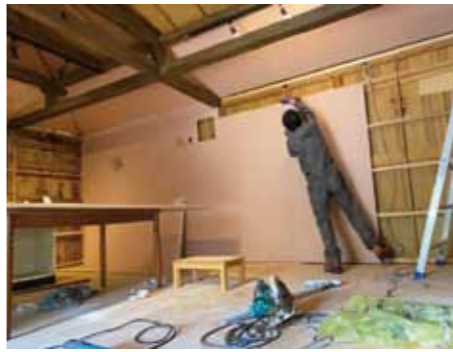
改修中の戸円の物件
