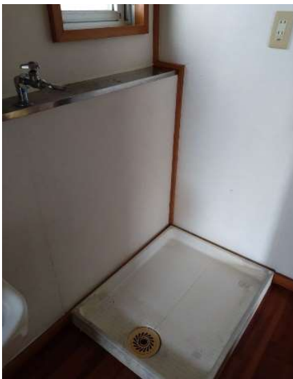
洗濯機設置場所
