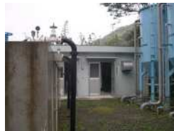
大金久浄水場
