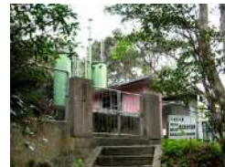
湯湾釜浄水場
