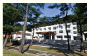
大和村防災センター
