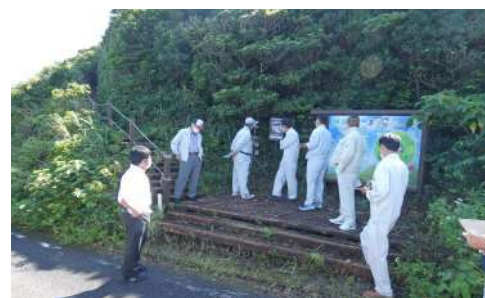
湯湾岳遊歩道： 手すり改修と滑り止め木材が設置された
