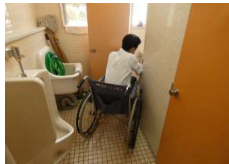
利用が困難なトイレ
