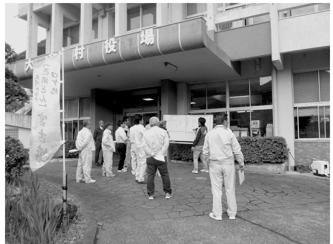
役場庁舎耐震改修工事
