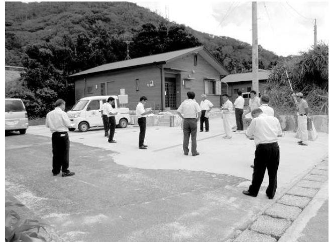
定住促進住宅建設工事 国直A棟、B棟（国直）
