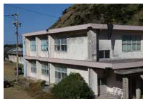
解体される特別校舎
