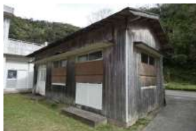
倉庫を新築して 発電機を設置
