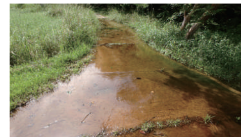
水路が詰まり、道に水があふれています
