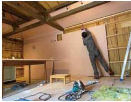
改修中の戸円の物件
